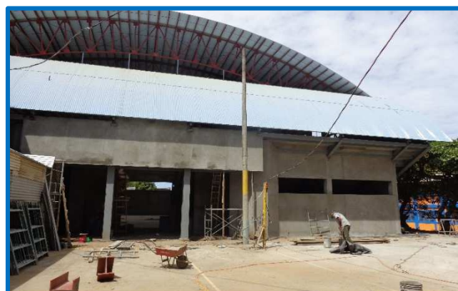
Observar fotografía de la vista panorámica del acceso a graderías.
