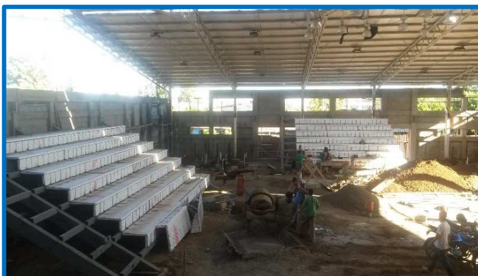
Observar vista interna de las instalaciones del Gimnasio de Boxeo, donde se aprecia la instalación de la estructura metálica principal de graderías y conformación de las mismas con covintec.
