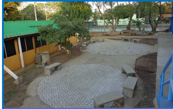
Vista panorámica de las obras exteriores
