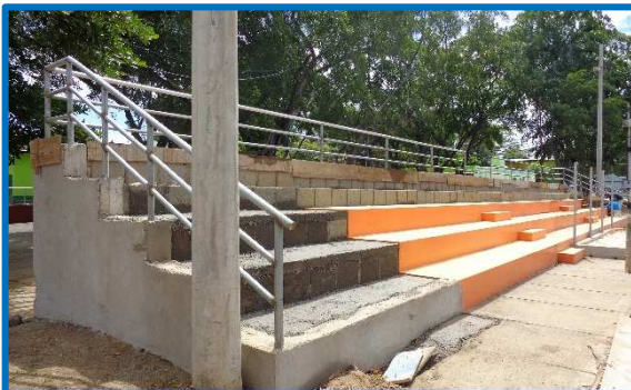
Vista panorámica de la ampliación de gradería costado Este.
